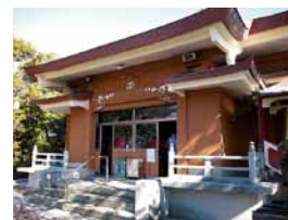
コンクリート造りの本堂は朱色に塗装
